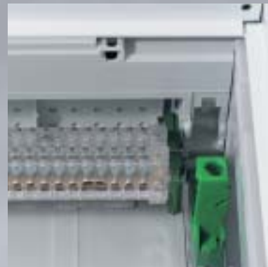
Легкое обращение – следует лишь защелкнуть систему шин N/PE.
